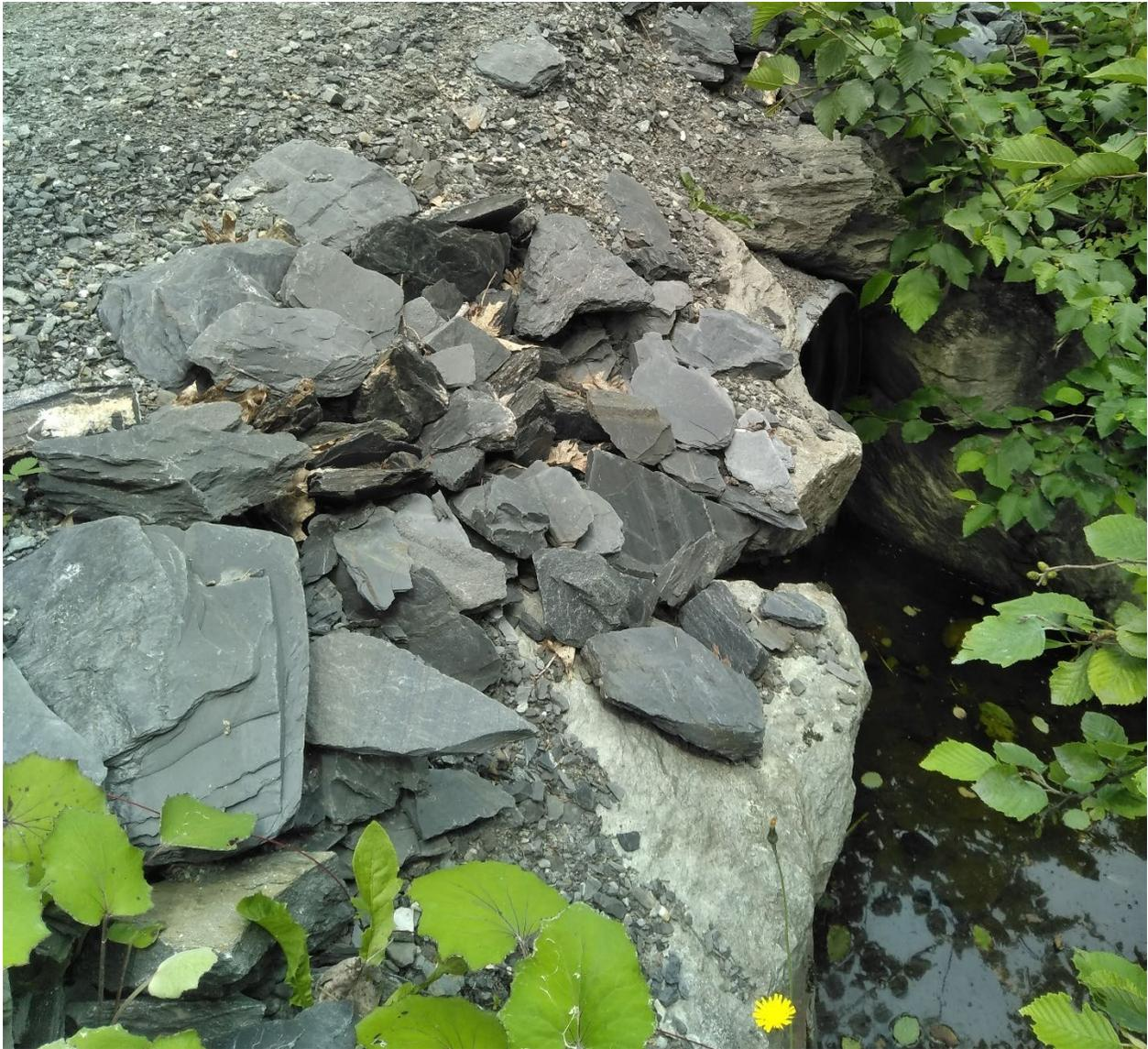
**Figure 16. Ponceau 2, avec érosion du tablier**
