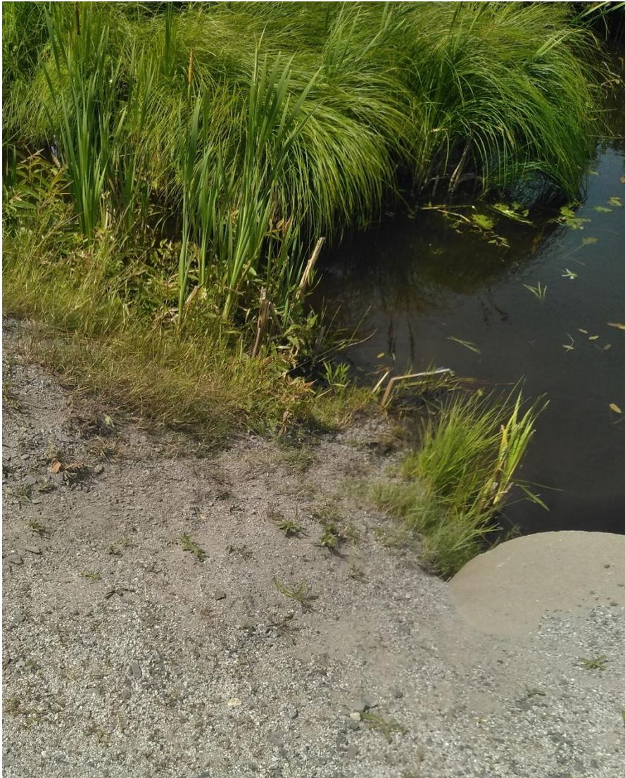
**Figure 17. Ponceau 3, avec érosion du tablier**
